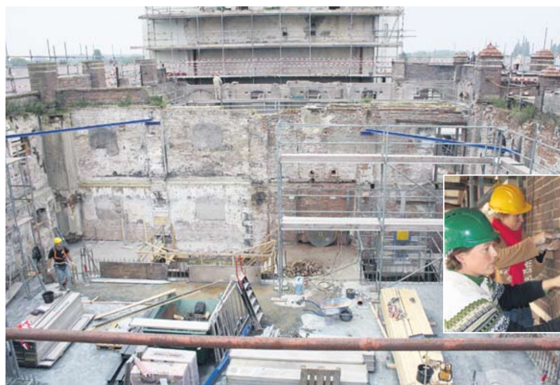
▲ Blik binnen de muren. De baksteengevels zijn bijna 14 meter hoog en verlopen in dikte van circa 45 centimeter aan de voet tot 30 centimeter bovenaan
